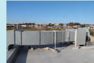
換気ダクトの整備
