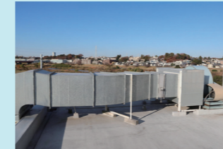
換気ダクトの整備
